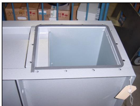
Рисунок 7. Нанесение уплотнительной ленты
