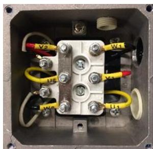
Figure 24 – Raccordement de la pompe à mazout
